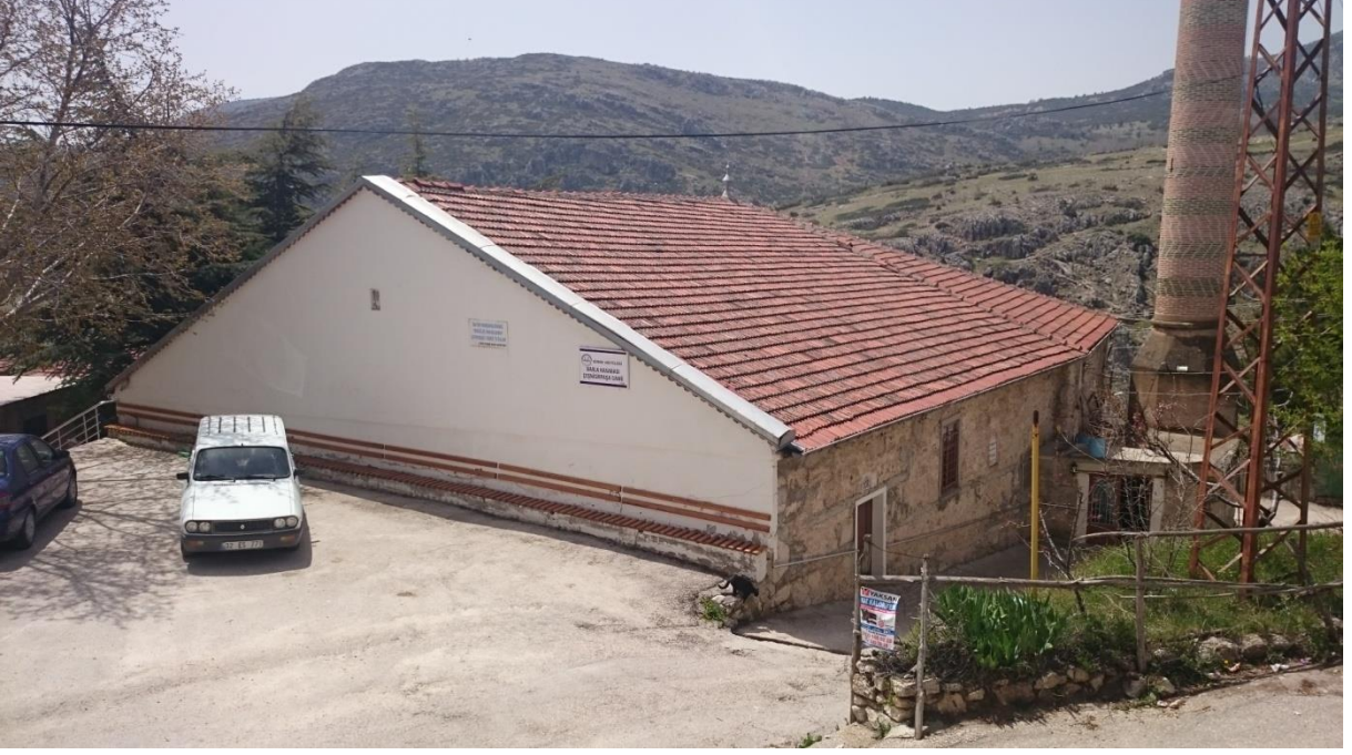
Restorasyon Öncesi Görünüm
