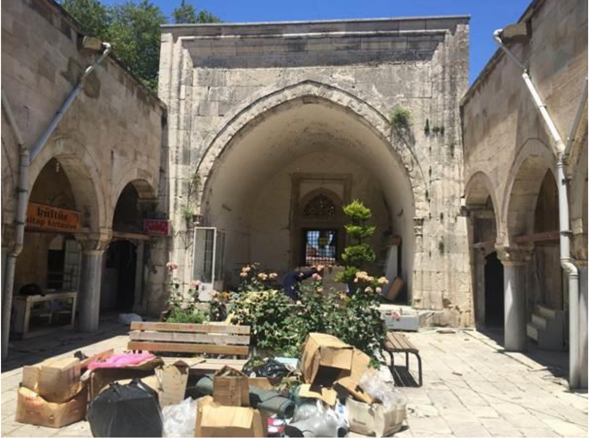
Onarım Öncesi Görünüm
