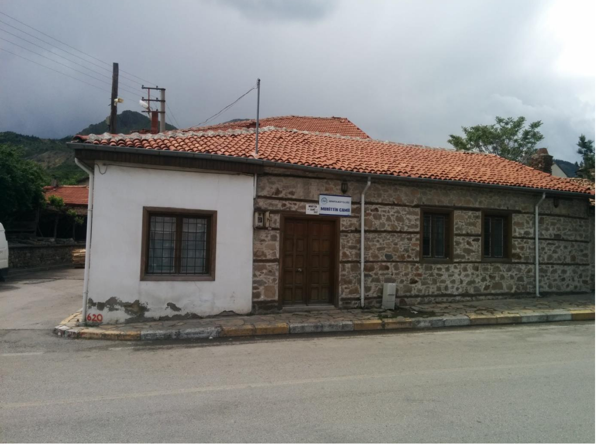
Onarım Öncesi Görünümü
